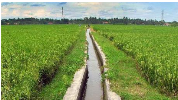
Gambar 10.4 Saluran kuartier (sumber : Kementerian PUPR, 2013)
